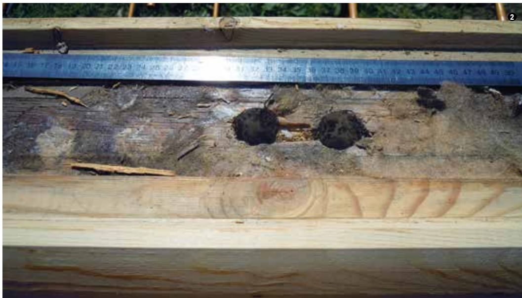
❷ Продольный паз стенового элемента с продольной теплоизоляцией в доме из клееного профилированного бруса. Вид после демонтажа
